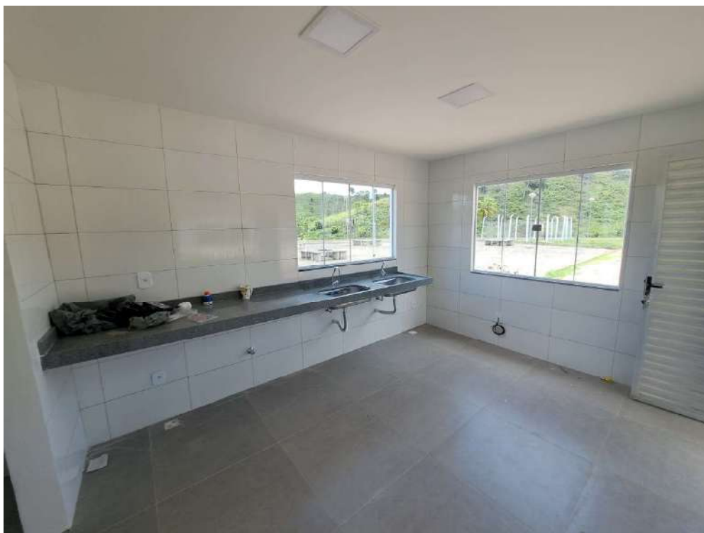
Figura 4: Espaço interno da cantina.
