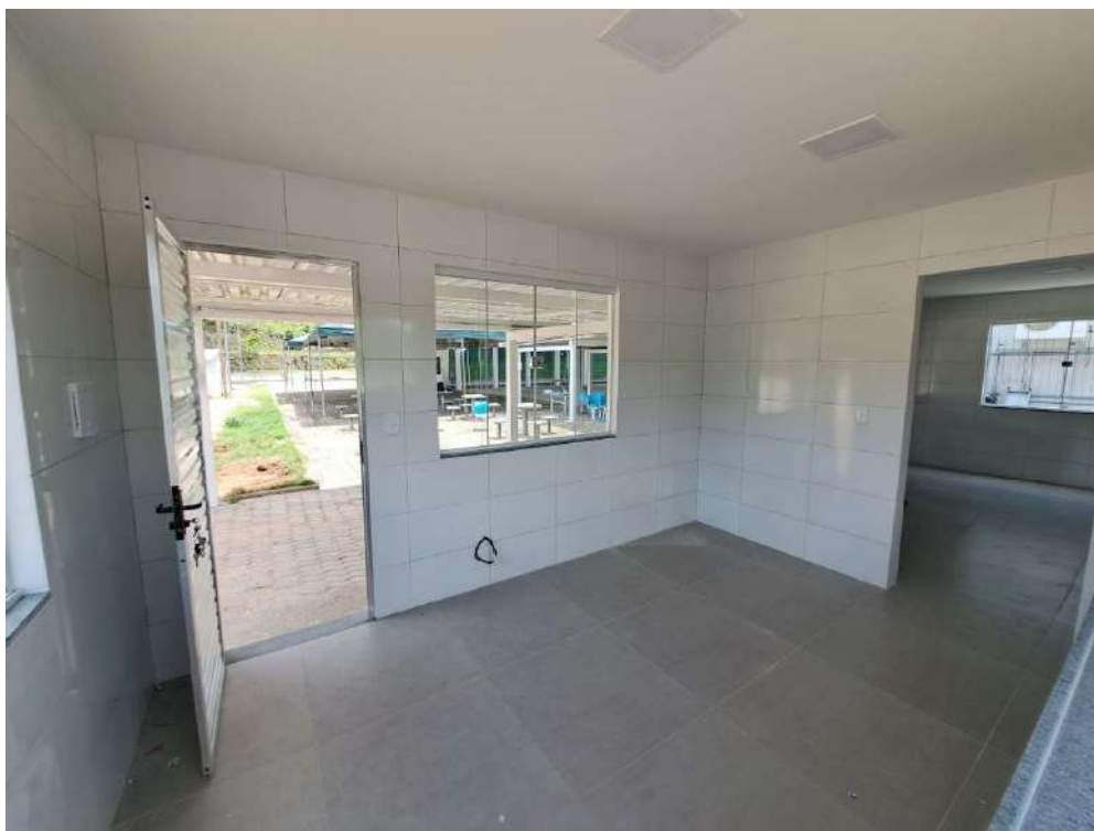
Figura 3: Espaço interno da cantina.
