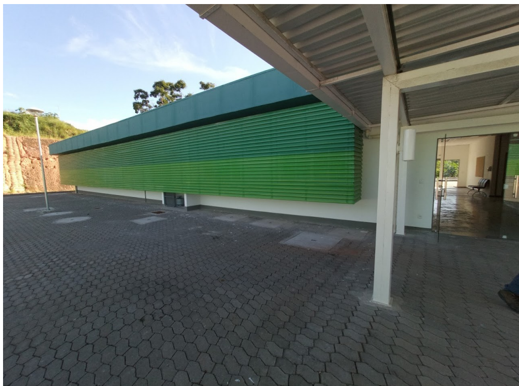
Figura 4: Vista da fachada da cozinha.
